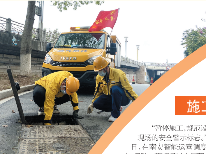
收到智慧井盖报警,工作人员赶往现场检查阀门井。
