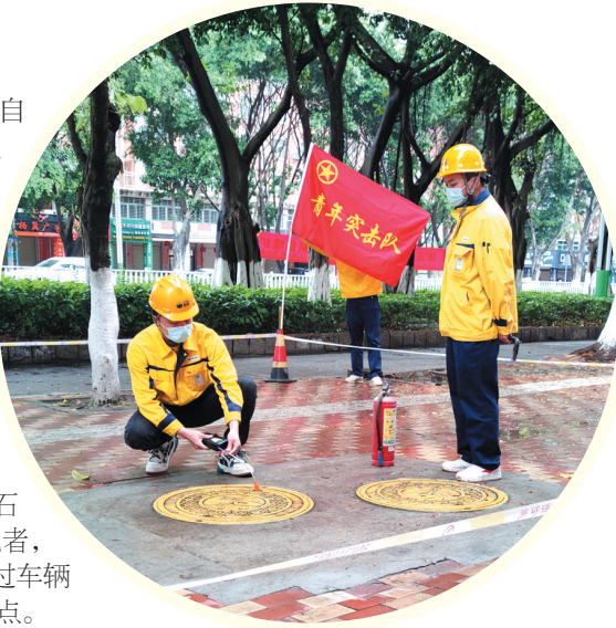
工作人员进行阀门井漏气检测。
