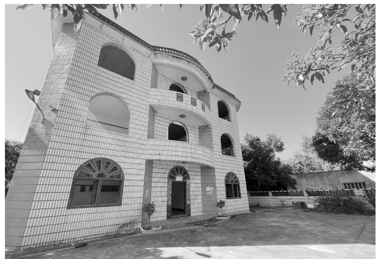
等待拆除的旧村部。
