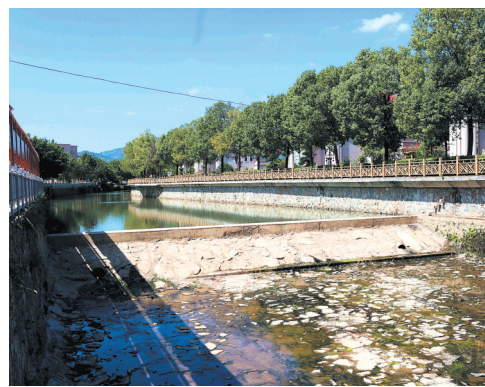
社一村重修雷公坝引水渠。
