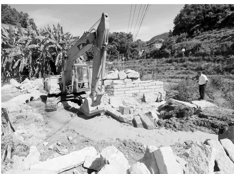
黄田村修建水坝工程,解决附近农田灌溉问题。
