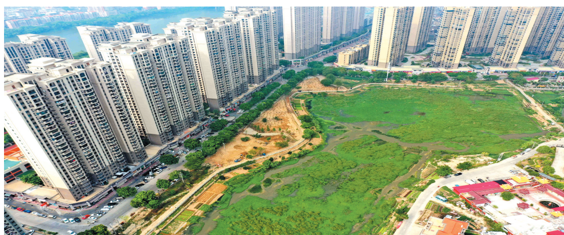
凤凰湖公园正在施工整治。
