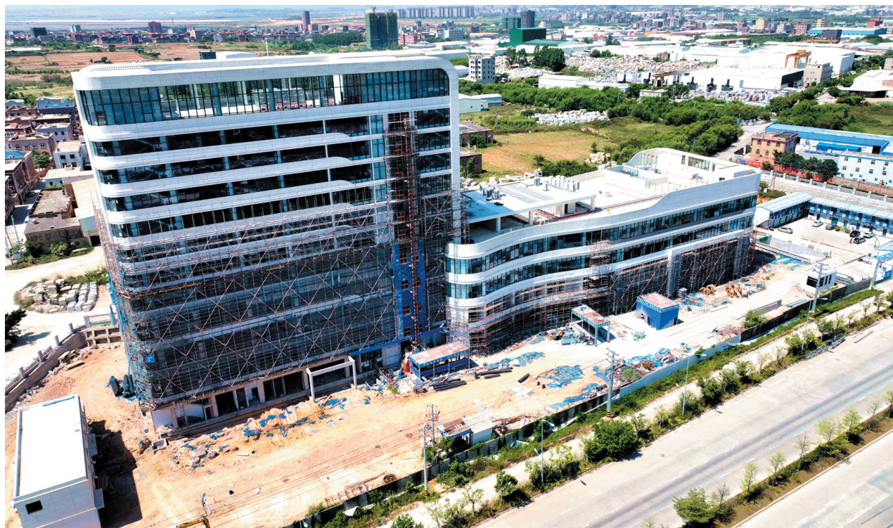
南安市成功医院新院区项目现场。
