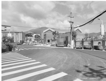
改造后的道路焕然一新。
