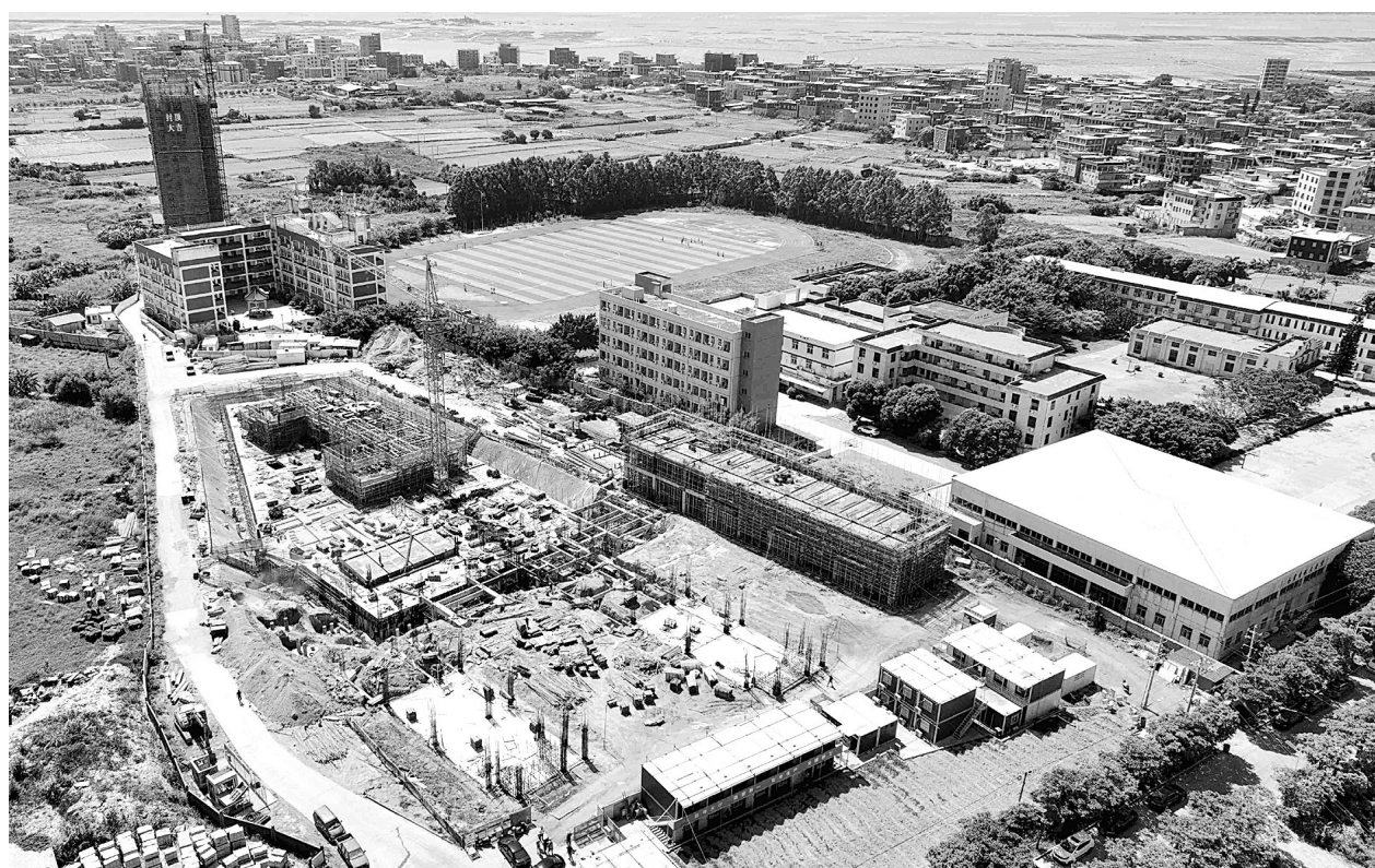
南安一中奎霞分校扩建施工现场。
