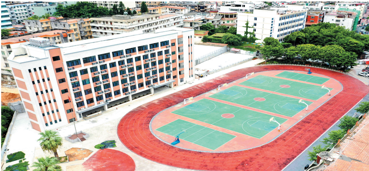
水头中学新建教学楼已经投入使用。
