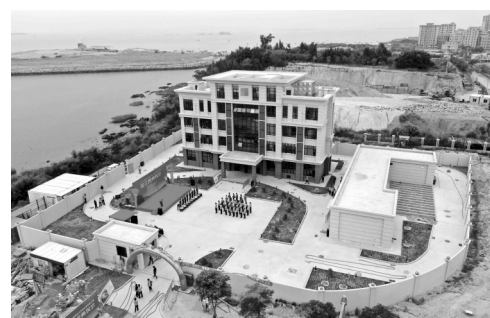
泉州海警局南安工作站业务用房竣工。
