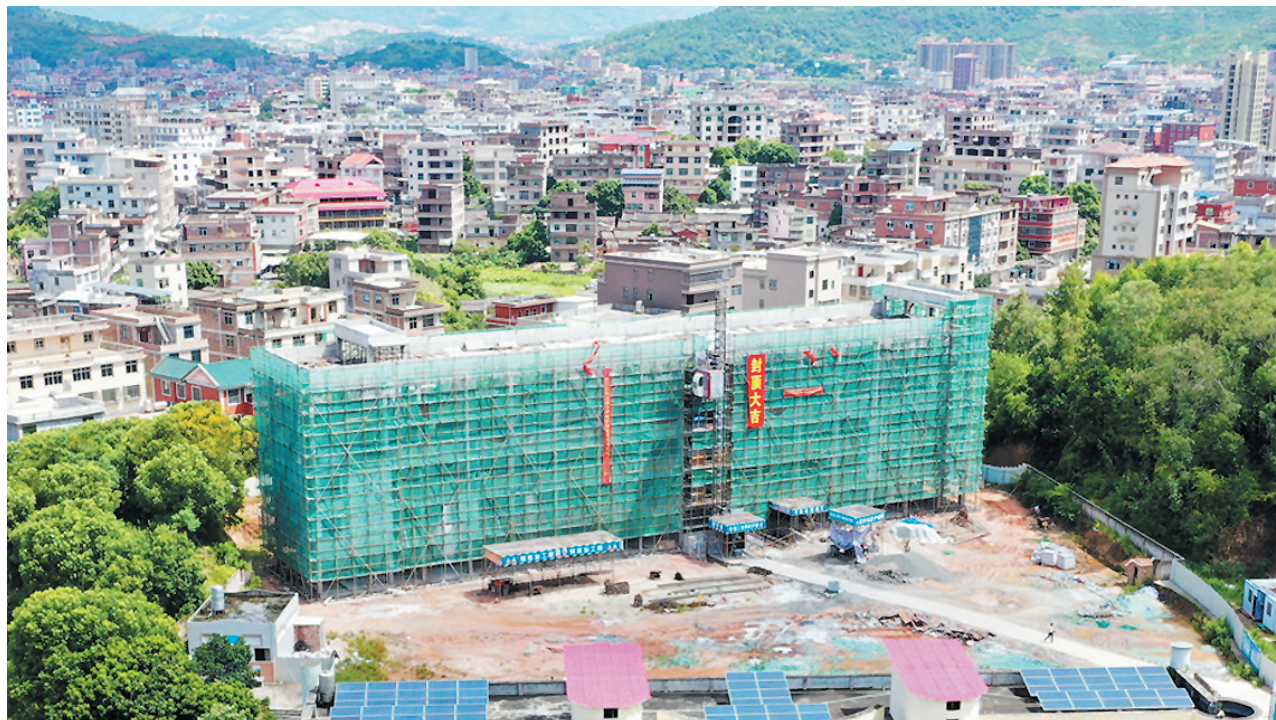
新教学综合楼位于原教学楼不远处,目前已经封顶。
