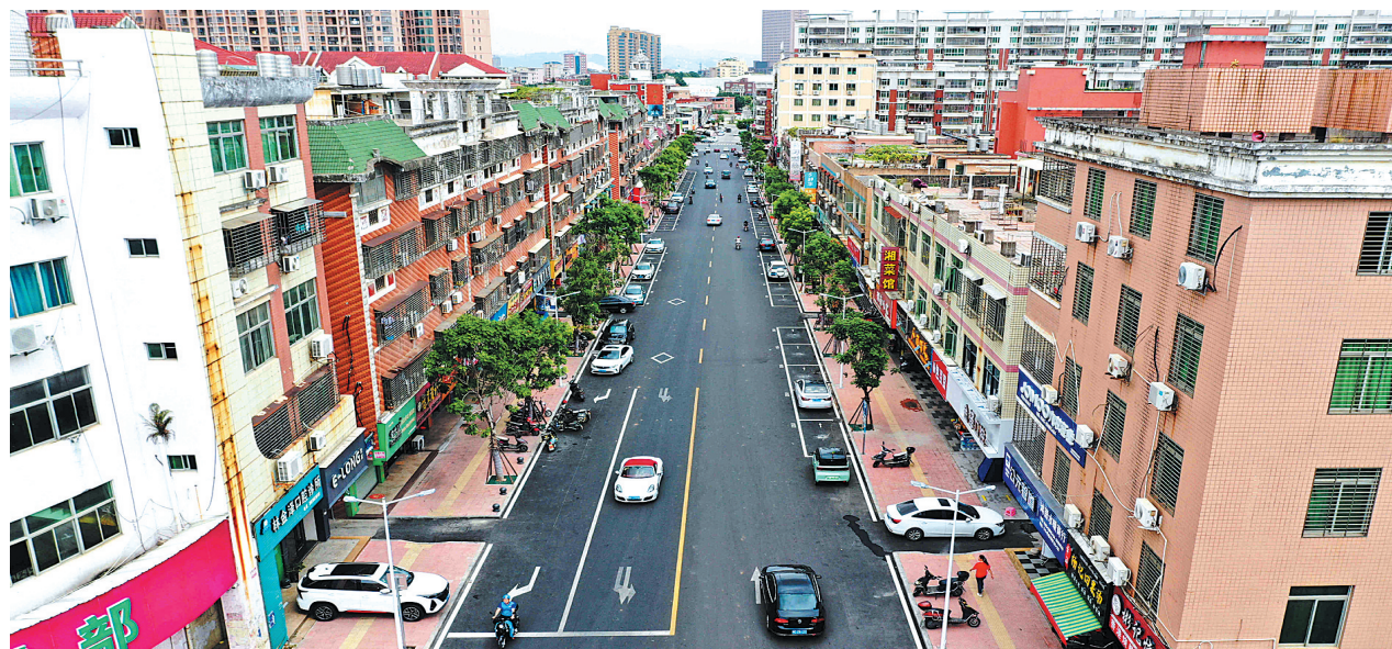
水头镇中心街区道路“白改黑”已经完工。
