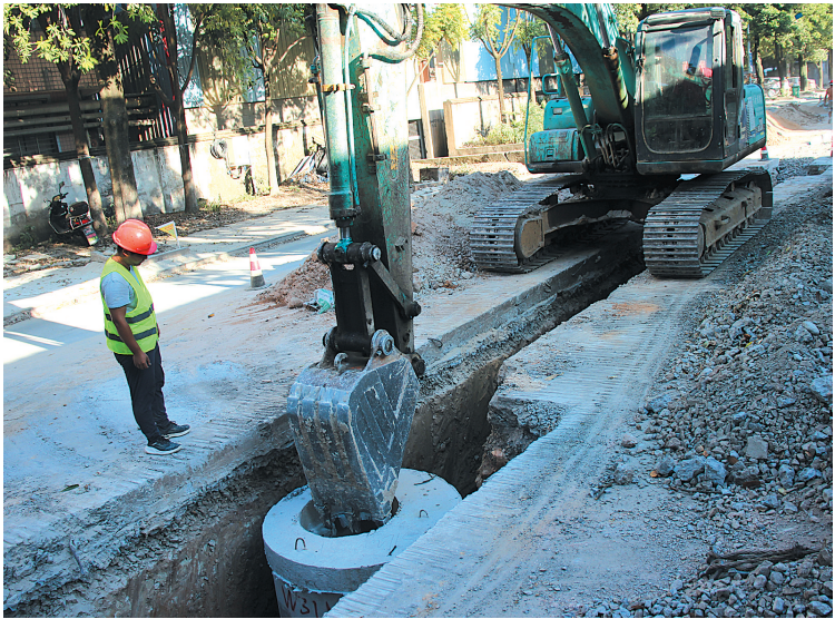
施工人员正埋设污水管道。
