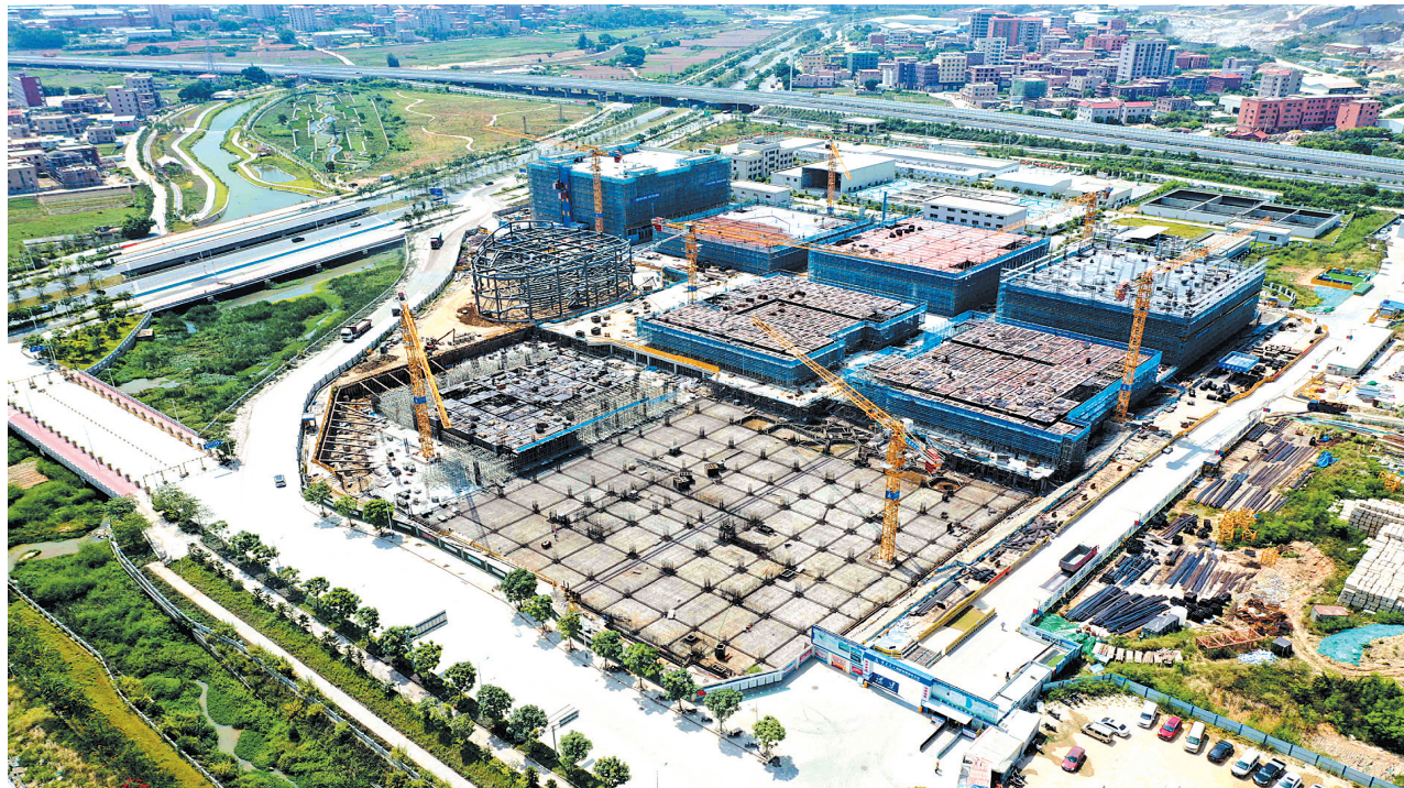
泉州芯谷南安科创中心项目施工现场。
