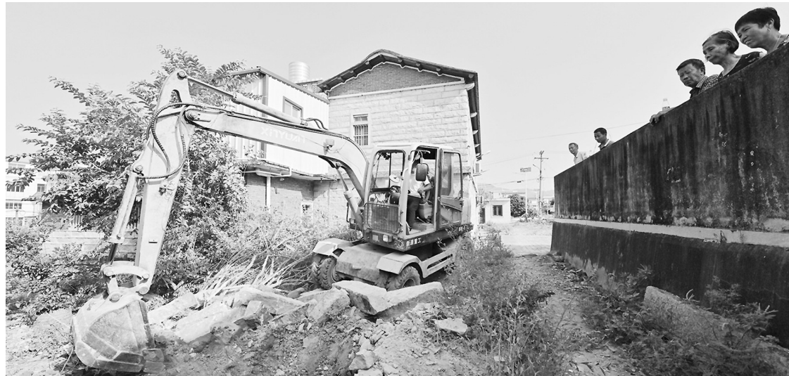
在村民的围观下,挖掘机正在平整地面。
