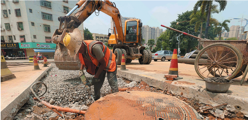
金庄霞光片区污水管网工程施工现场。
