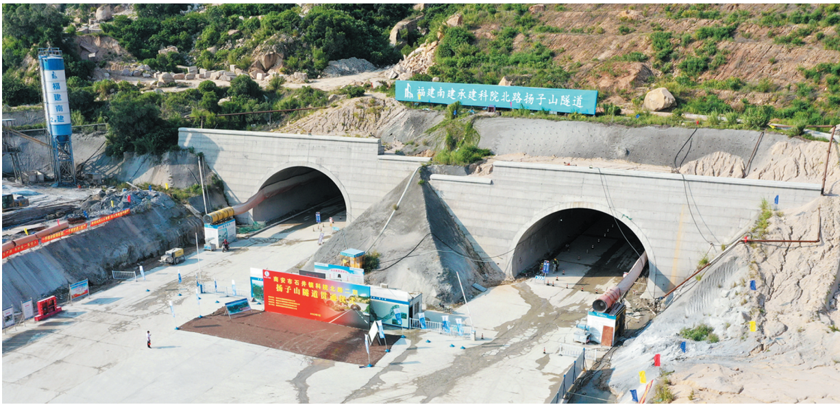
已顺利贯通的扬子山隧道（科院北路二期）。
