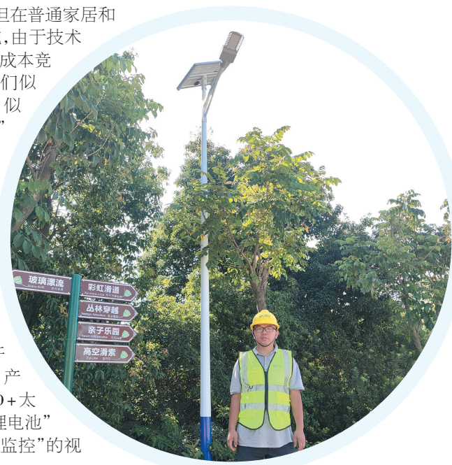
世光照明将产品应用于美丽乡村道路照明亮化工程。
