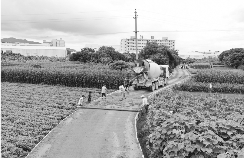
原本狭窄的土路正在进行硬化改造。
