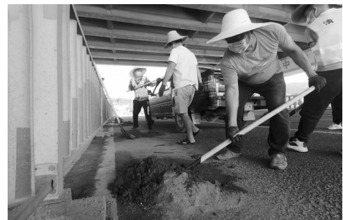
驾驶员正在清扫路面。
