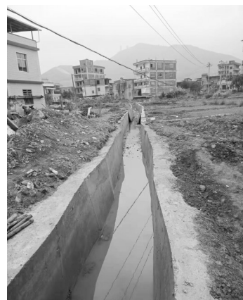
炉山村的排山洪渠已完工投用。
