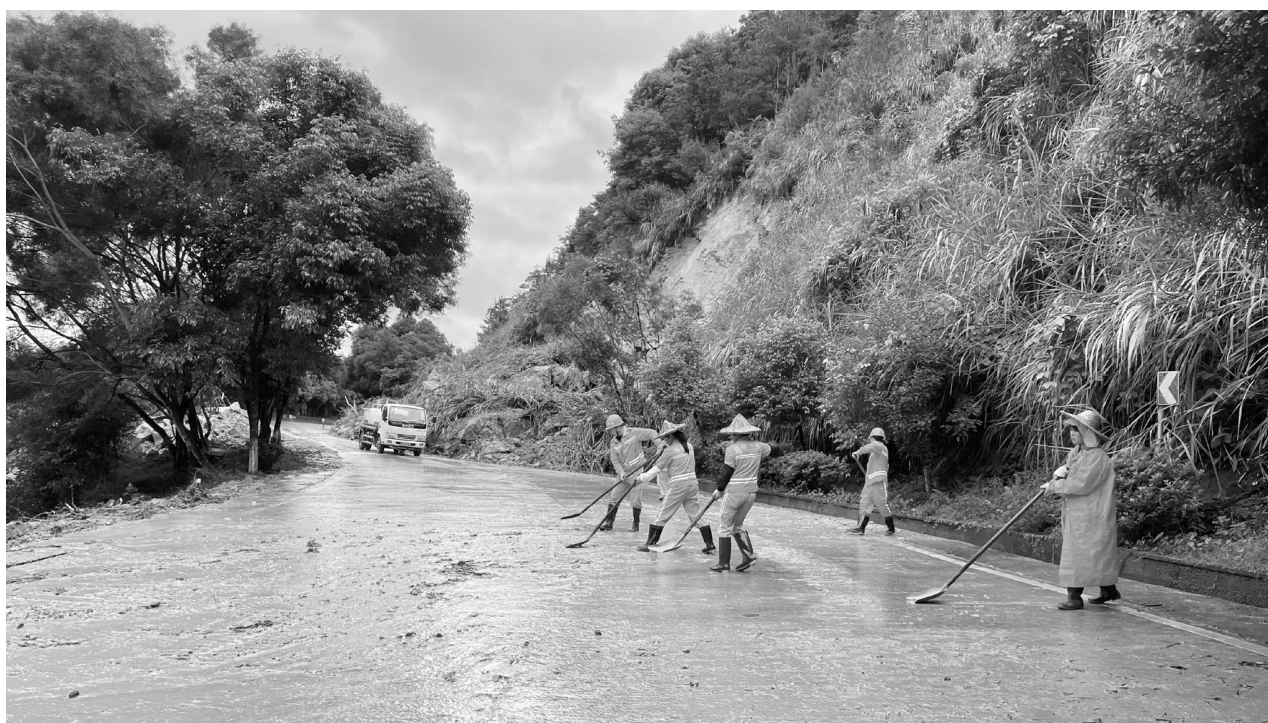
工人正在清理现场。
