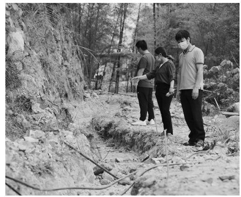
引水渠沿山体而建,目前正在建设中。
