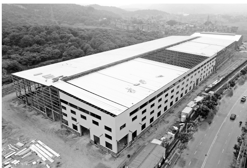
恒利达工程机械一期项目施工现场。
