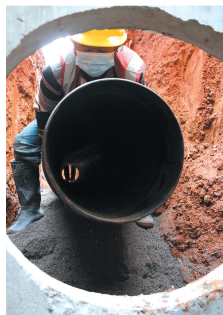
工人正将污水管与检查井对接。
