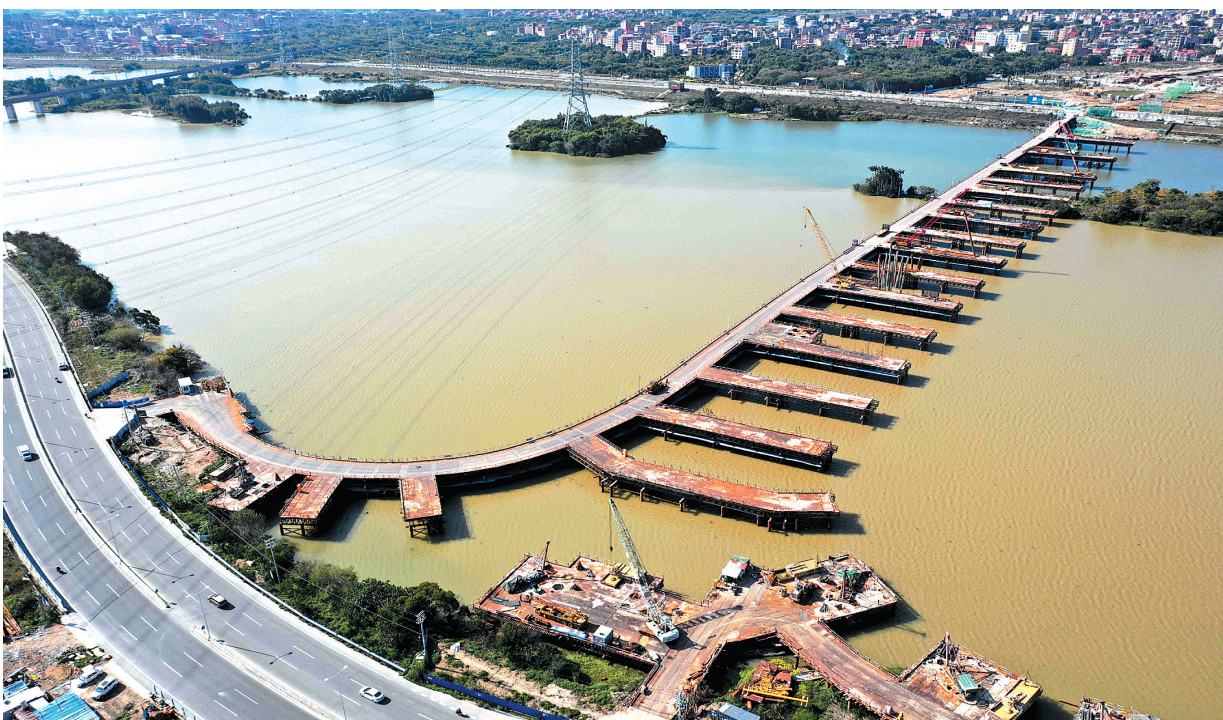
武荣大桥项目施工现场。
