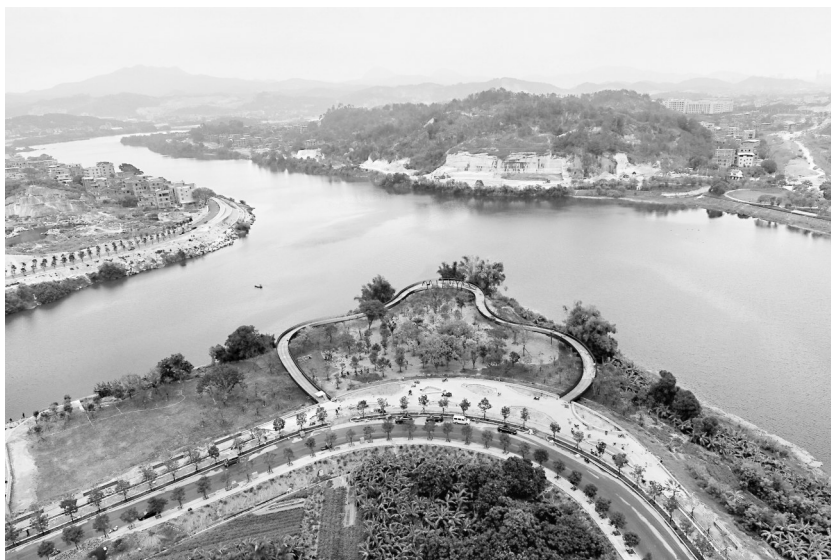
“两溪一湾”安全生态水系综合整治工程滨溪北路A2段项目现场。
