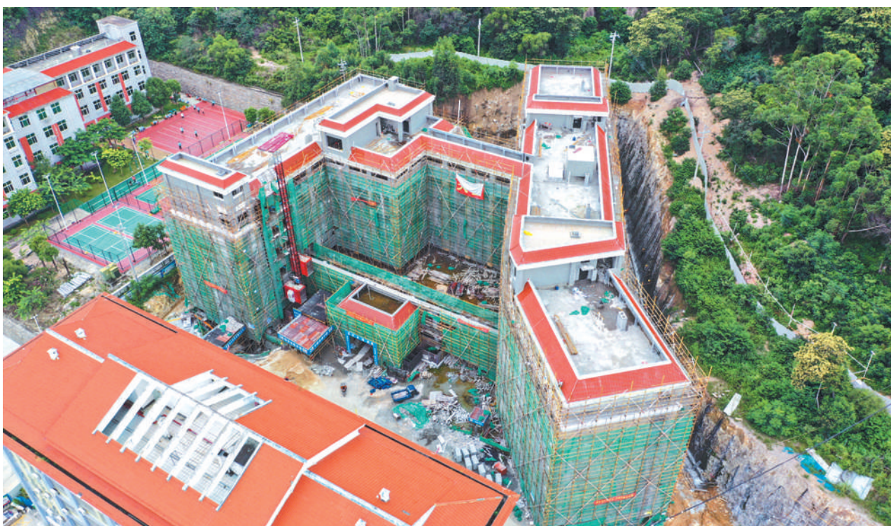
已经进入外立面装修的南安市老年人养护院老年公寓大楼。
