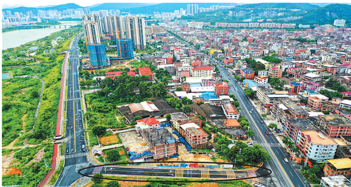
崎峰段纵五路（画圈处）打通了江滨路崎峰段与省道 308 线，缓解了省道 308 线的交通压力。
