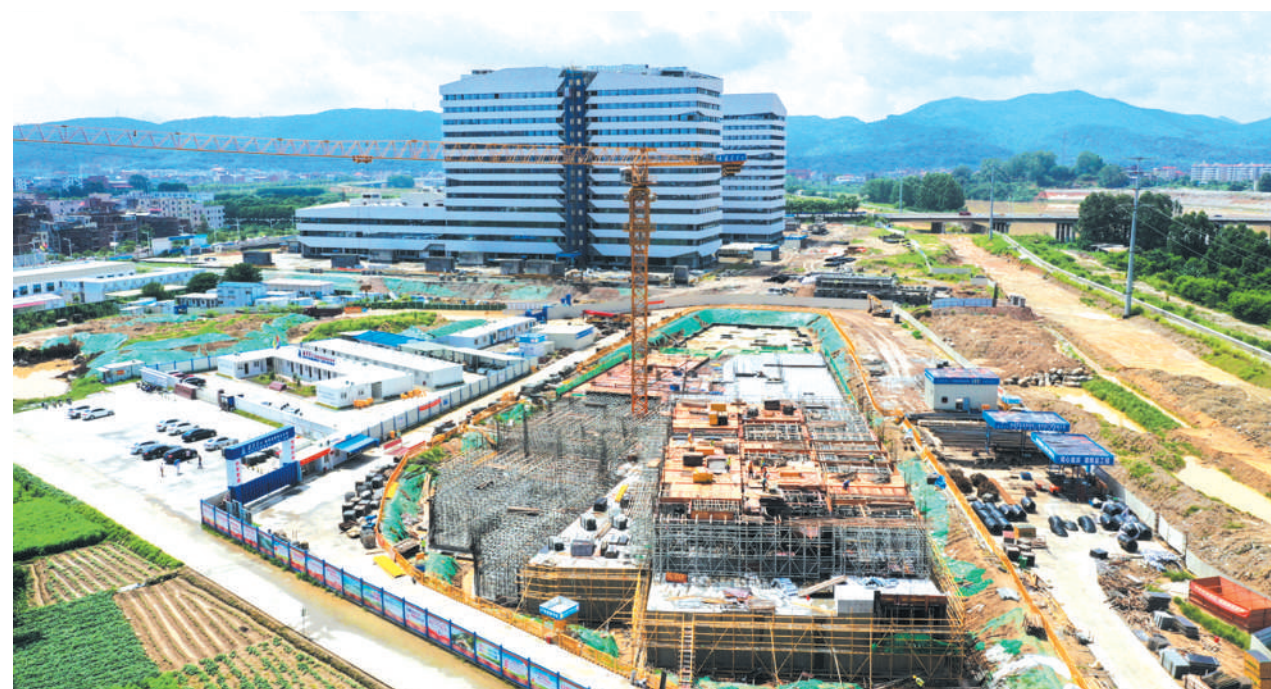
建设中的南安市医院新院区二期项目。
