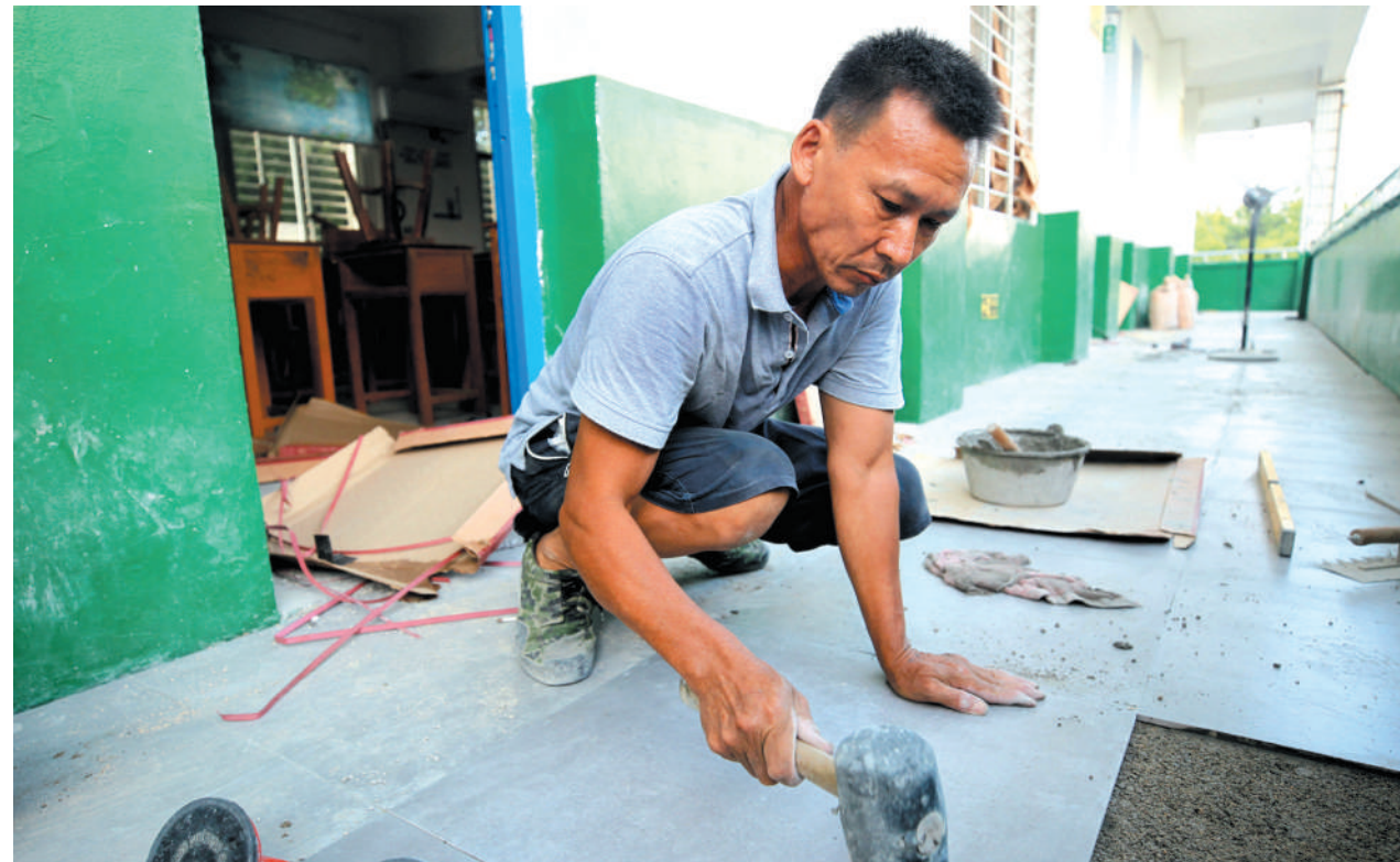
工人在铺设教学楼地面瓷砖。
