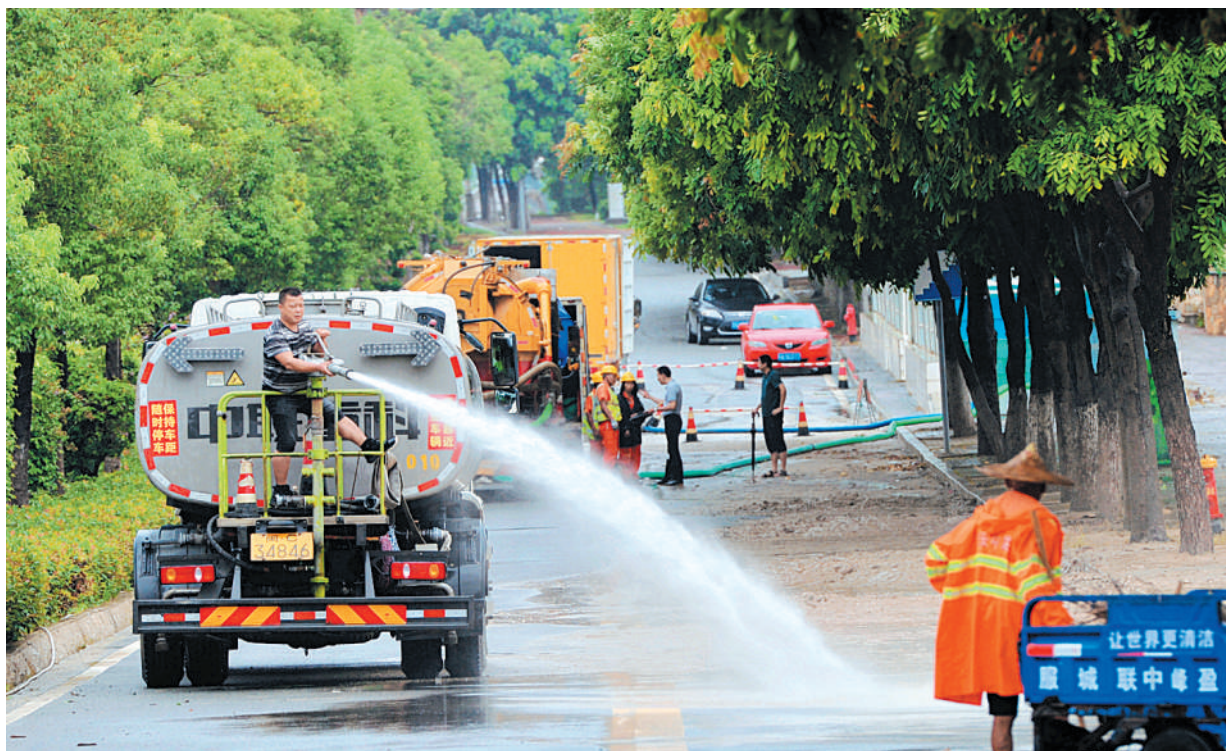
暴雨间隙,市政环卫的工人们抓紧清理路面因积水留下的淤泥,疏通下水管道保障路面排水。
