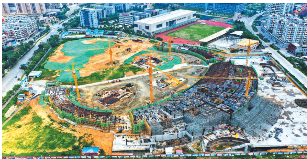
项目施工现场。
