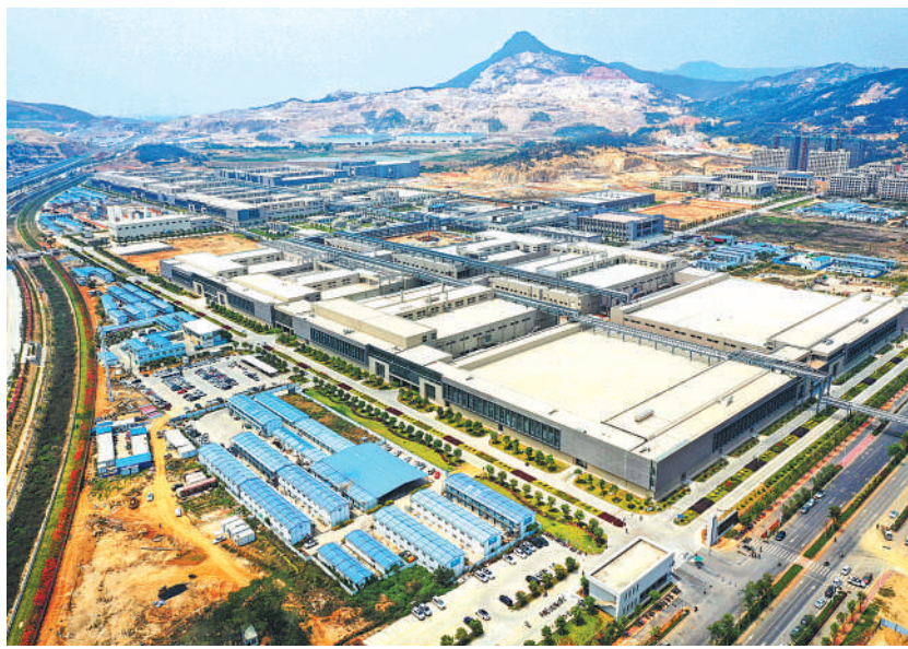
第一季度南安重点项目建设超时序开展,图为泉州三安南安分园区施工现场。
