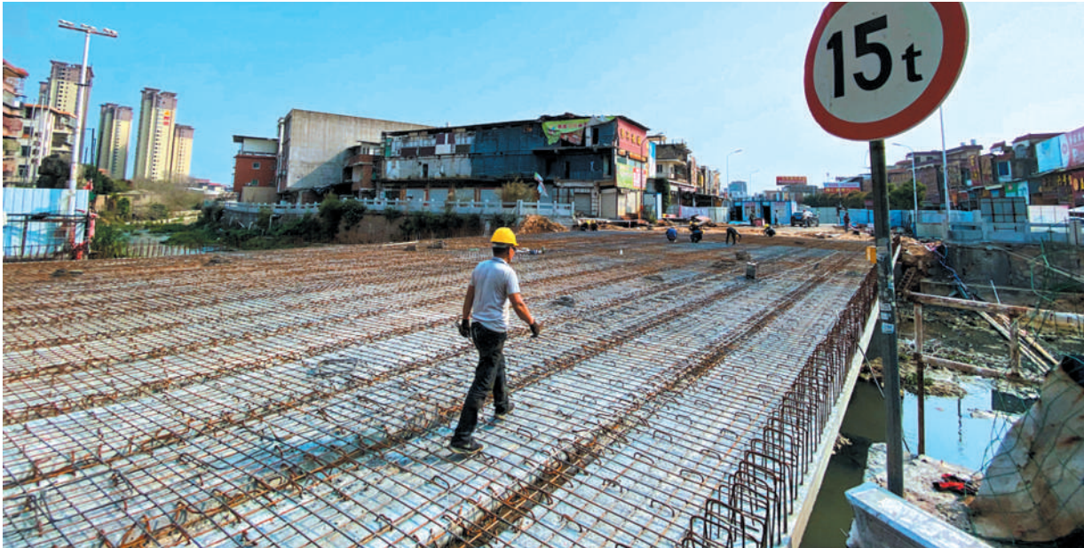
重建中的美人桥，即将铺设桥面。
