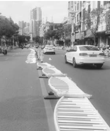
正在布设的隔离栏。
