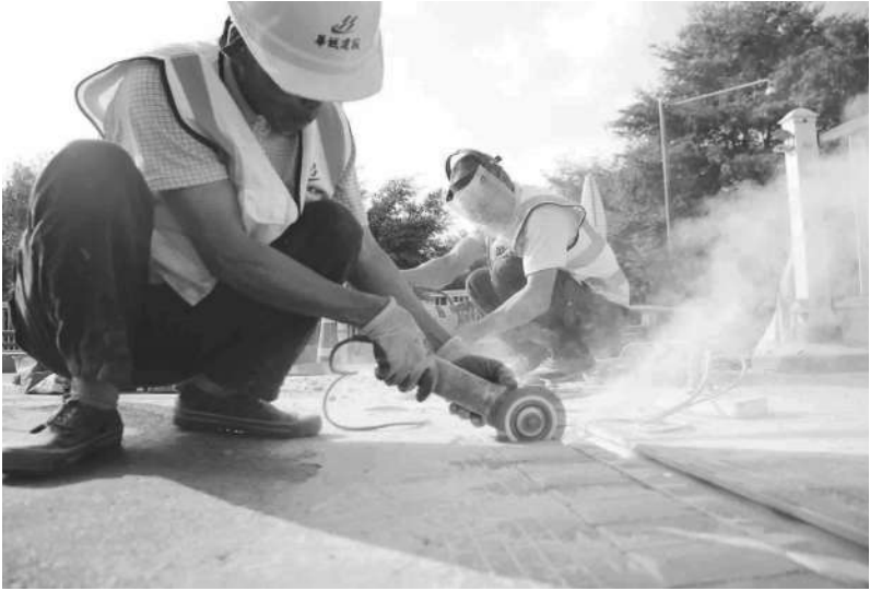
工人对美林大桥的伸缩缝进行修复。
