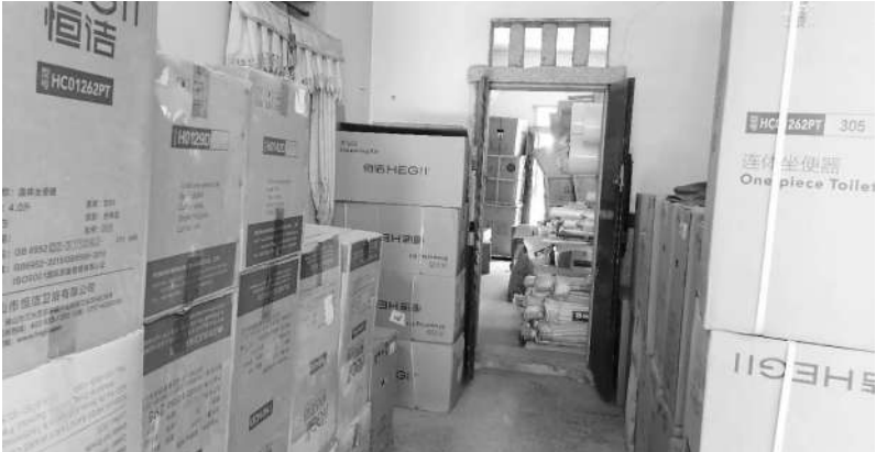
后房村一区21号仓储内部材料堆放堵塞了部分疏散通道。
