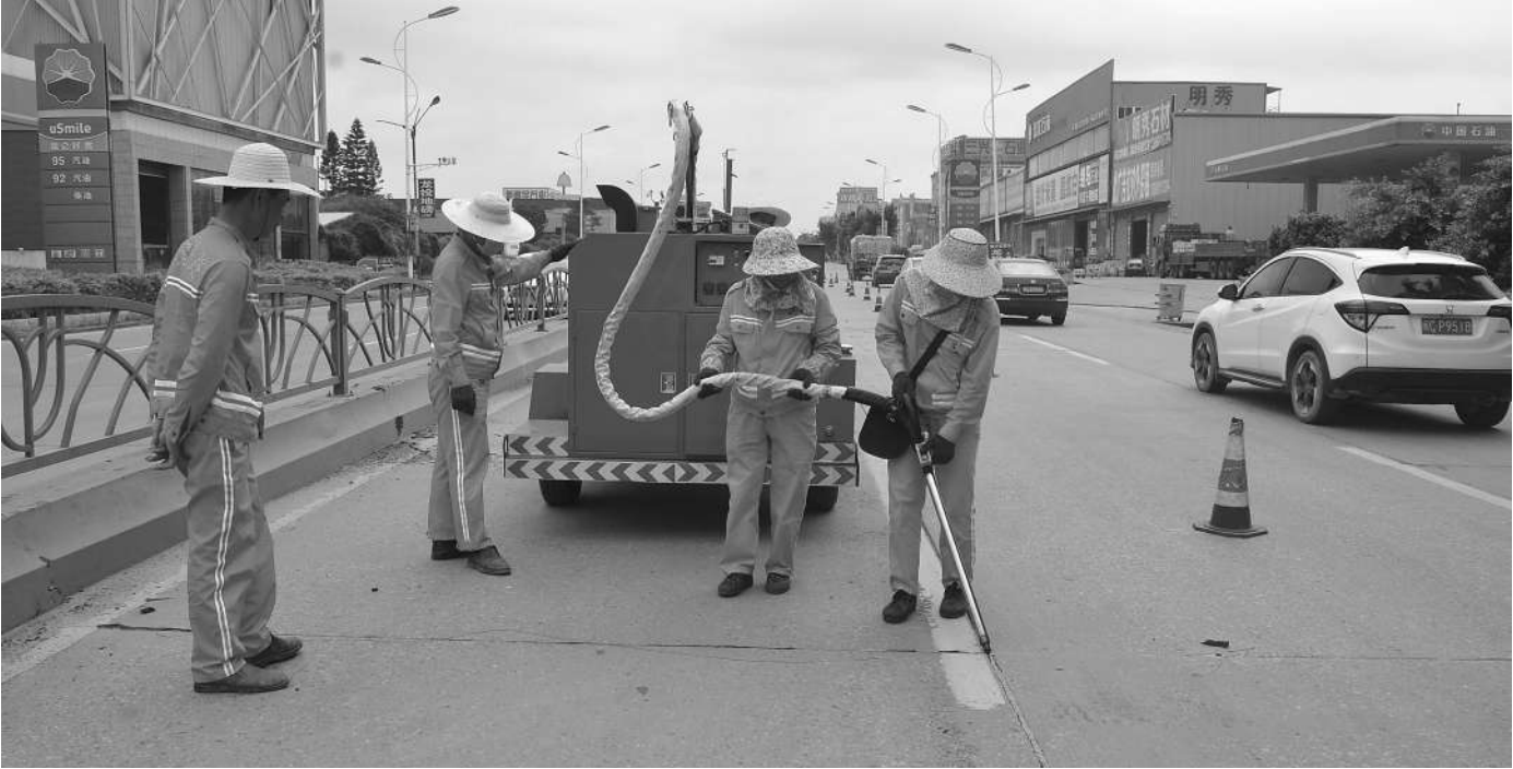
国道324线水头段养路工人利用自行式灌缝一体机开展清灌缝作业。
