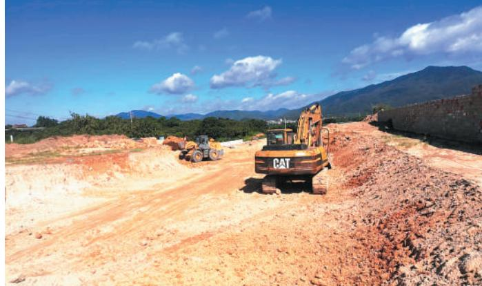
国省干线横八线洪濑镇区过境线公路工程起于原省道307线（与洪四公路交叉口处），路线途经扬美村，跨过东溪，后穿过西林村，沿线与南洪公路平面交叉，路线终于纵三线省新至梅山公路雪峰段，全长4.074公里，设有大桥307.16m/1座，小桥22.04m/1座，采用二级公路兼城市主干道技术标准建设，设计速度60km/h，路基宽度32.38m，水泥混凝土路面宽度23m，双向六车道，项目预算总金额19892万元。目前，终点段合同约定内容已基本完成，2020年8月28日已先行通过交工验收投入使用；起点段K0+000-K0+220路段正在施工路面结构层，K0+220-K1+650路段已完成水泥混凝土路面施工，正在进行路缘石安装等扫尾工作；东溪大桥已基本完成；预计国庆节起点路段可完工。
