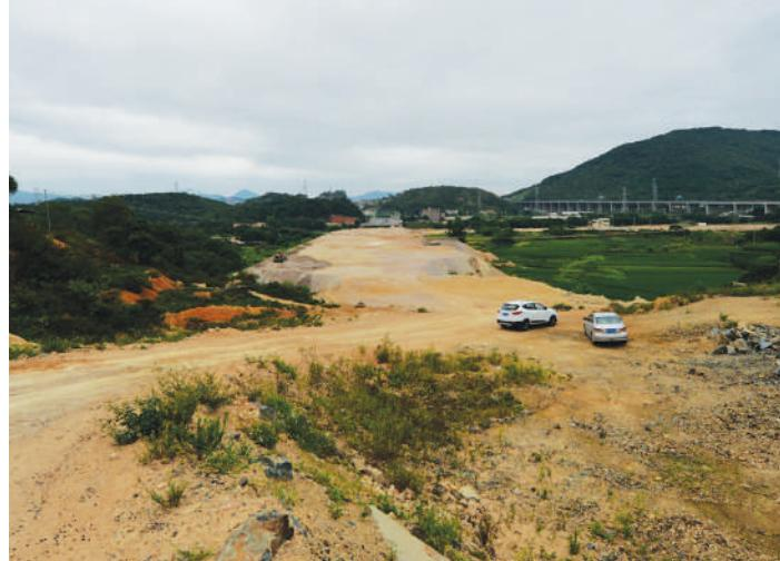
南安市成功大道科教中心段位于柳城街道办事处，起点桑林东埔并与成功大道市民中心段相连，终点与晋平大桥连接。全长2.35公里，路基宽42米，设计时速50km/h，双向六车道城市一级主干道，项目总投资约17000万元，已完
