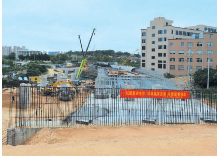
江滨南路二期从杏埔大桥处开始至江滨南路金塔段连接点为止，全线长3.3公里，路面宽50米，双向6车道，设计时速60公里/小时，按城市主干道I级设计，总投资3.4亿元。目前，道路已完成2.4公里沥青铺设，高渠大桥完成右幅第二联支架安装，底模安装及支架预压；完成右幅第一联满堂支架基础硬化及1-2号墩部分满堂支架搭设；金鸡山引水隧洞保护工程小桥完成左幅桥空心板梁安装；金山路口完成全部水泥稳定基本摊铺，完成左幅主道沥青路面摊铺。
