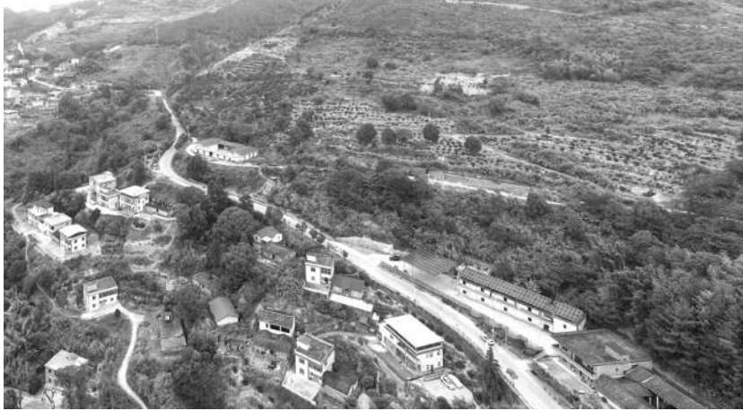
尽管县道331线蓬华镇新村村段正在修缮,但路面依旧干净整洁,没有过多的碎土渣。
