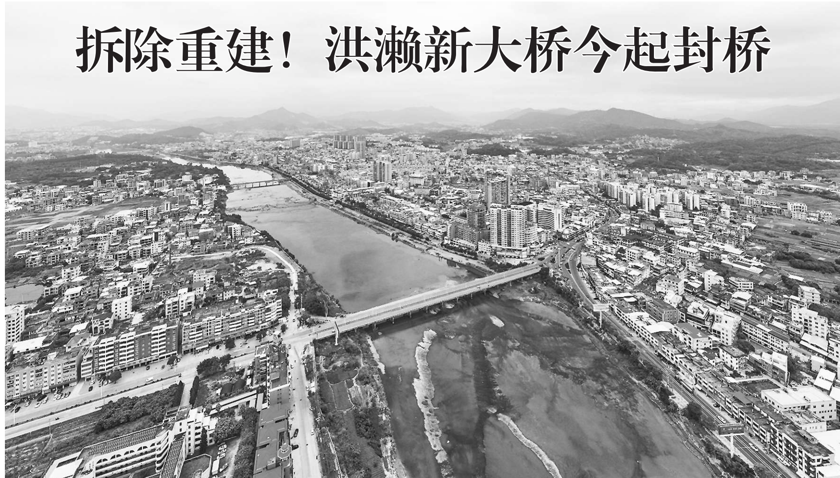
横跨东溪两岸,便利多少南安民众,洪濂新大桥将重建。
